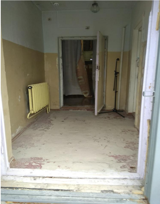
Фото №24 – эвакуационный вход
