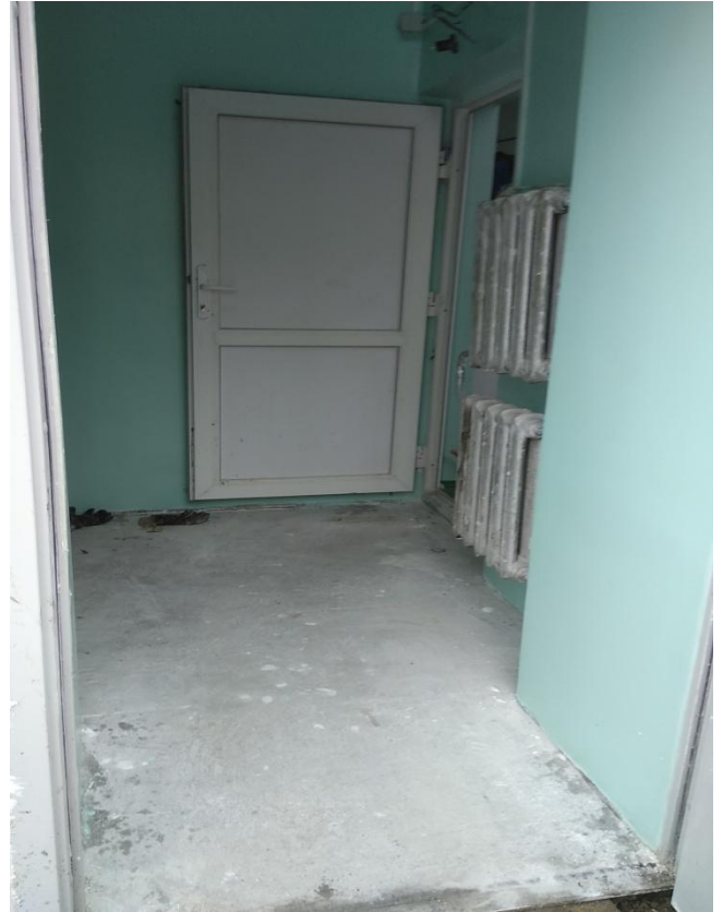
Фото №25 – эвакуационный вход
