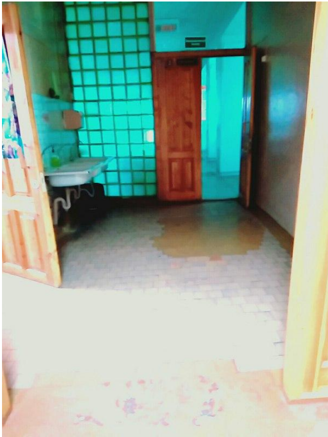
Фото №9 – вход в столовую)
