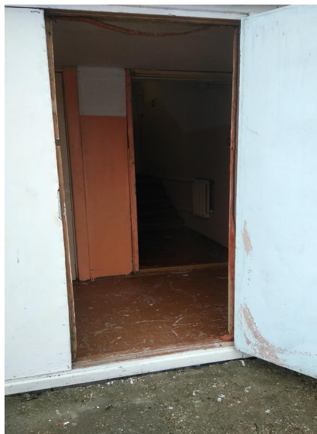
Фото №23 – эвакуационный вход
