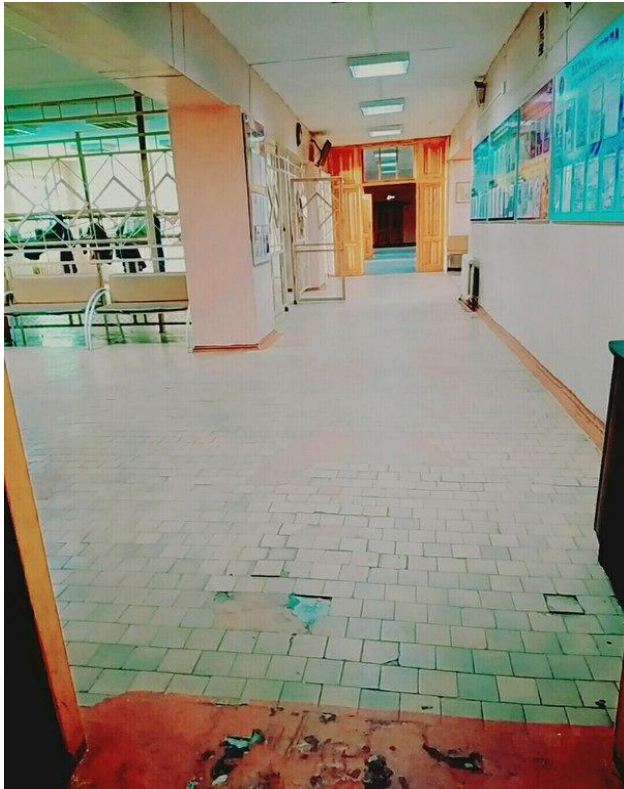
Фото №7 холл, вестибюль
